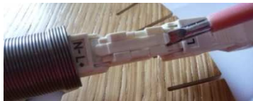
4-Insérez le ressort du module de câblage dans celui de BulM S (boursuflure à l'extrémité)
