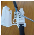
bloc de jonction : tournevis plat 2.5 mm – Attention au sens de la gaine
