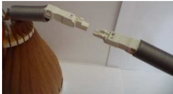
1-Préparez les modules (éclairage et câblage)
